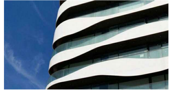
METAL SHEET CLADDING A: WHITE
